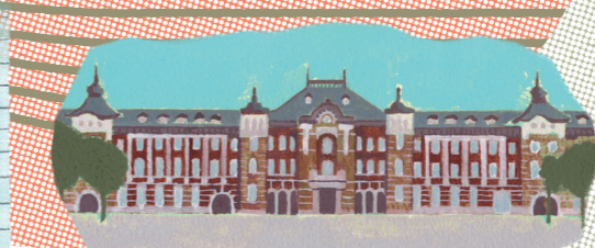
A 東京駅丸の内駅舎
